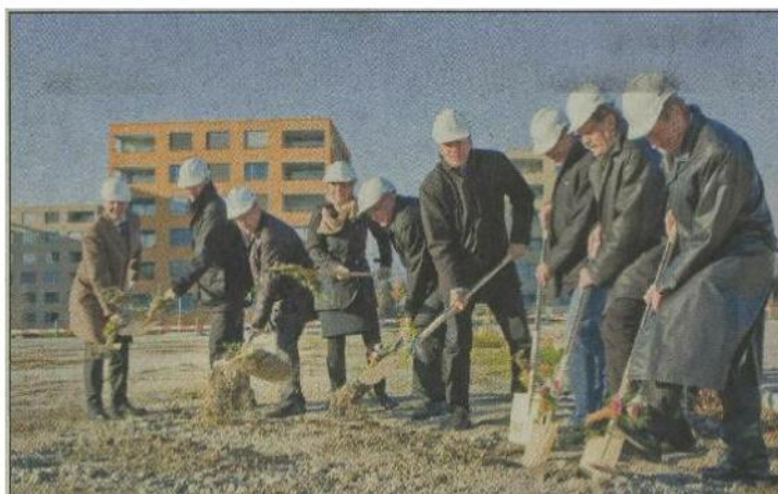
Mit Schwung und Blümchen den Spatenstich vollzogen. Der Lyssbachpark soll dereinst eine Attraktion werden. BT
